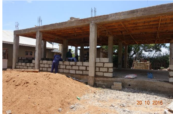
Arbeiten am Neubau der Schlosserei.
