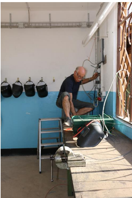
Experte Franz Granwehr baut die elektrische Installation auf.
